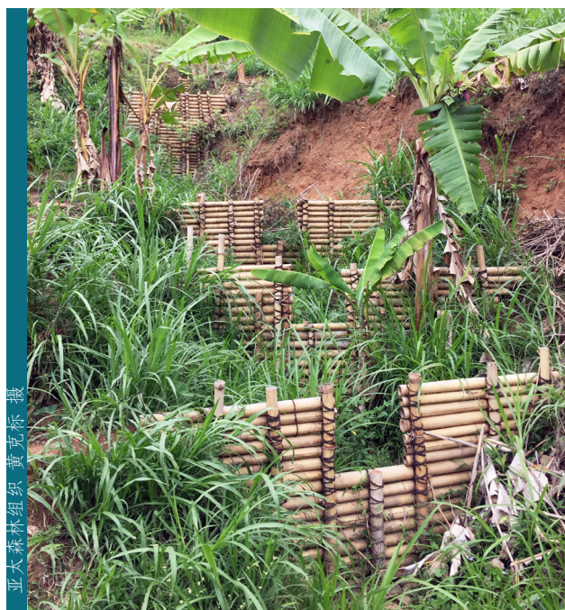
项目点利用竹子控制沟壑侵蚀
