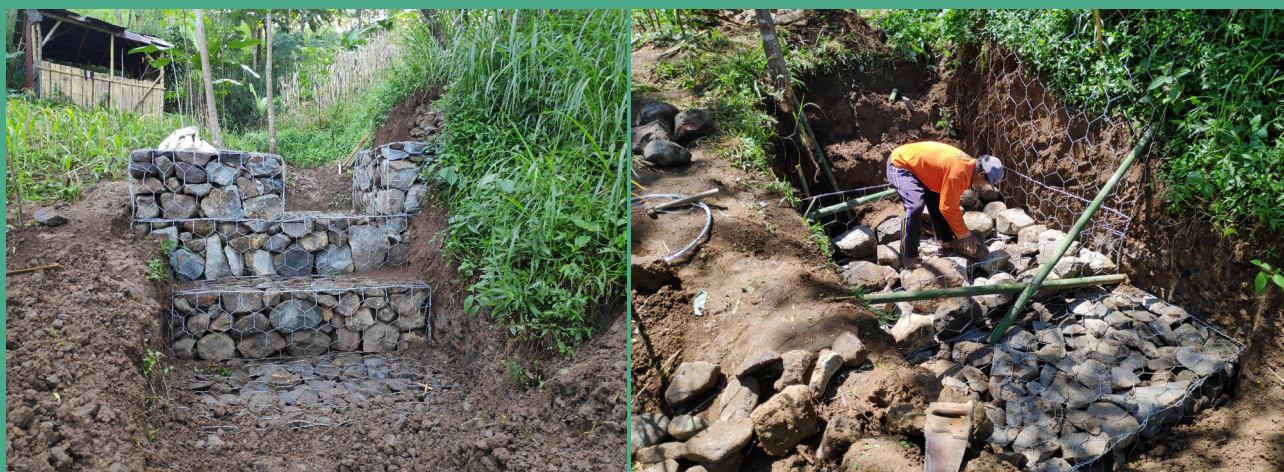
项目中使用的冲沟侵蚀控制结构——石笼（左）以及竹子和石笼（右）。水流域管理技术中心 摄
